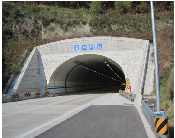
5공구 불로터널(상주방향) 종점부
