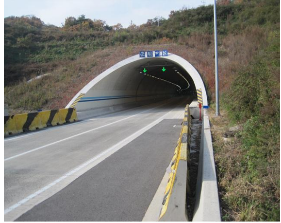
3공구 군위터널(상주방향) 종점부
