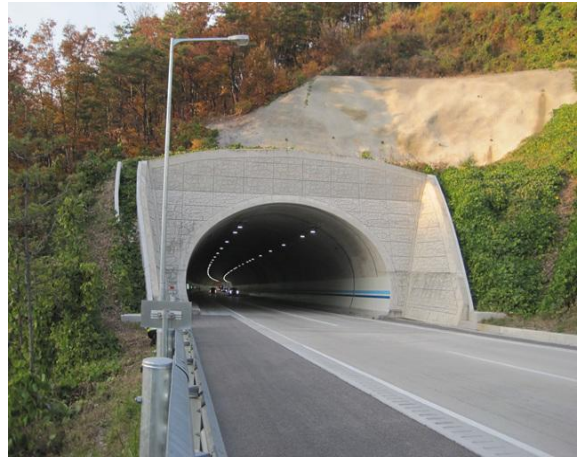
4공구 산법터널(영천방향) 종점부
