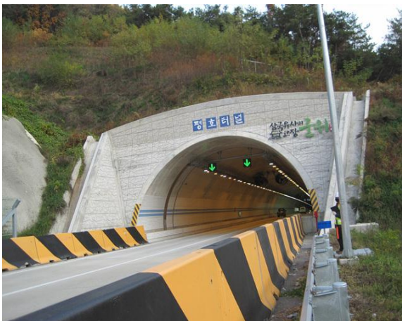
4공구 평호터널(영천방향) 시점부
