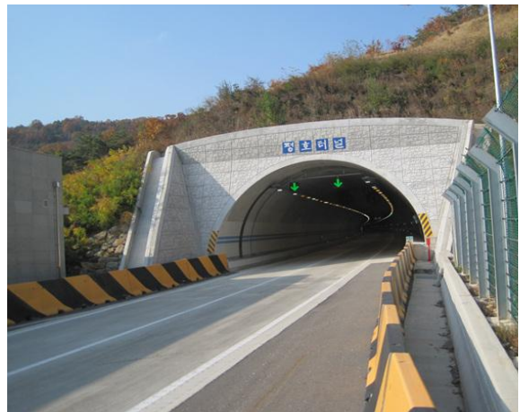
4공구 평호터널(상주방향) 종점부
