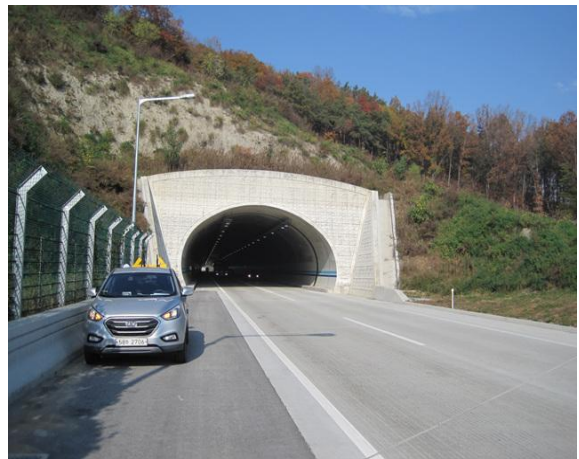
5공구 불로터널(영천방향) 종점부
