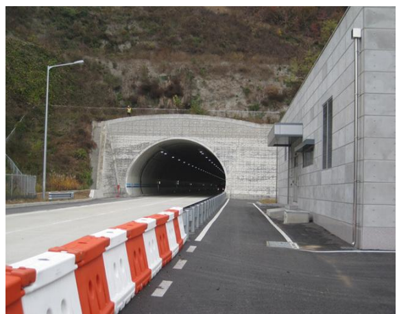
5공구 효령터널(영천방향) 종점부
