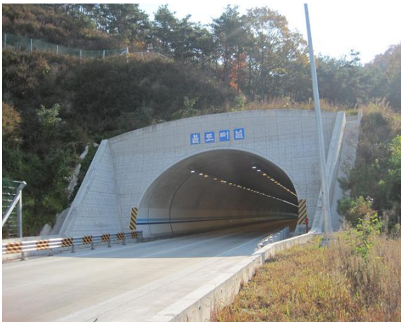
5공구 불로터널(영천방향) 시점부
