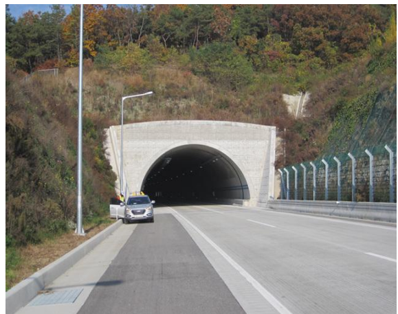
4공구 평호터널(영천방향) 종점부
