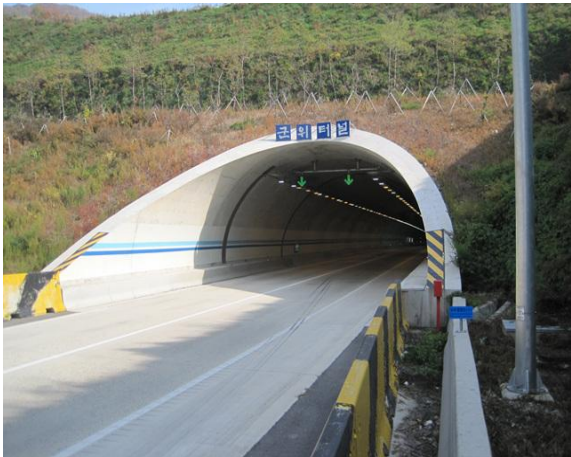
3공구 군위터널(영천방향) 시점부
