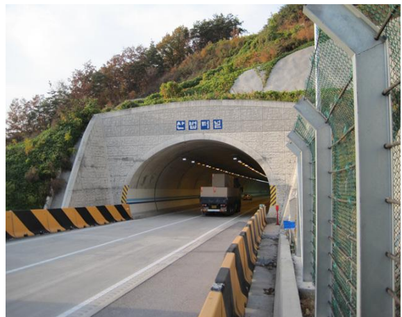
4공구 산법터널(상주방향) 종점부
