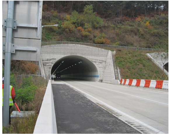
5공구 중구터널(영천방향) 종점부
