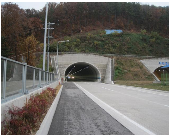
5공구 중구터널(상주방향) 시점부
