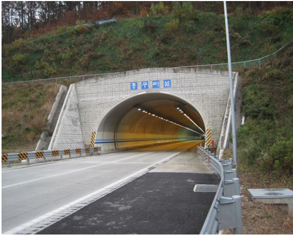
5공구 중구터널(영천방향) 시점부
