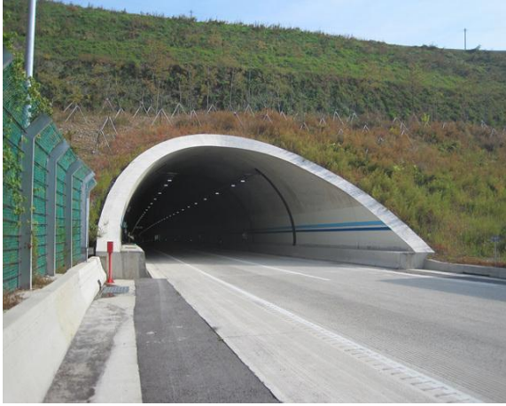
3공구 군위터널(상주방향) 시점부
