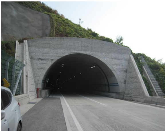
4공구 평호터널(상주방향) 시점부
