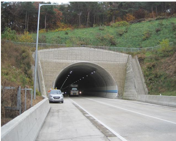
5공구 효령터널(상주방향) 시점부
