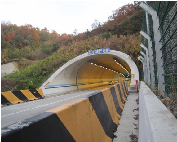
4공구 산법터널(영천방향) 시점부
