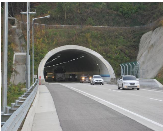
4공구 산법터널(상주방향) 시점부
