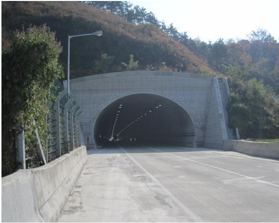
5공구 불로터널(상주방향) 시점부
